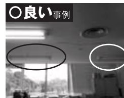
○ 良い事例 中央診療棟 控室 外光利用により室内灯を間引き消灯されていました。
