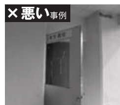
× 悪い事例 講義棟 講義室 講義中で冷房されていましたが、後部ドアが開放された状態でした。冷気が逃げています。
