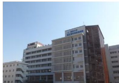
第二病棟 北側より
