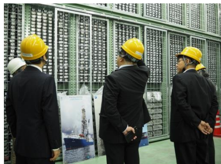
新冷蔵保管庫@B棟
