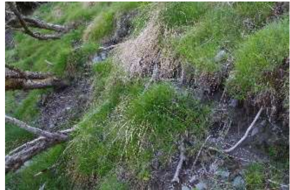
図 1 転倒したクマノミズキの根元上部の亀裂とイ
