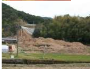
図3 判読した土砂災害と現地写真
