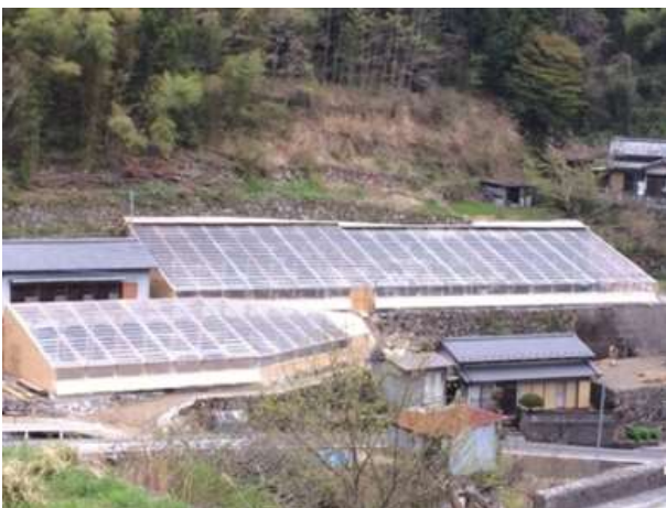
図1 石垣蓄熱ハウスの外観
