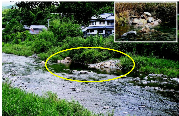
写真2. 水制と淵 白枠内は、石積みによる水制の様子。
