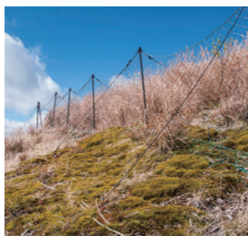
防護柵内で生長する植物
