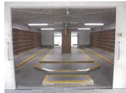
昇降口 (改修後)
