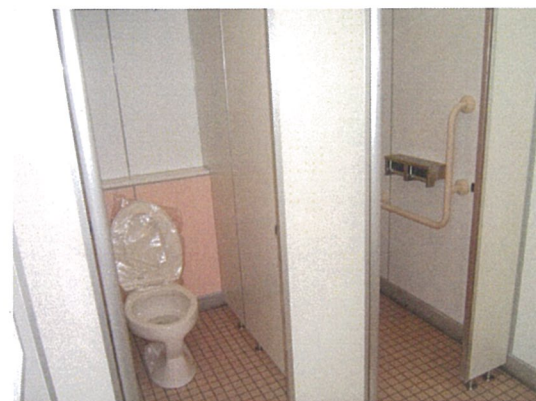
女子トイレ (改修後)
