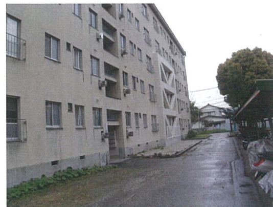
北面外観 (改修後)
