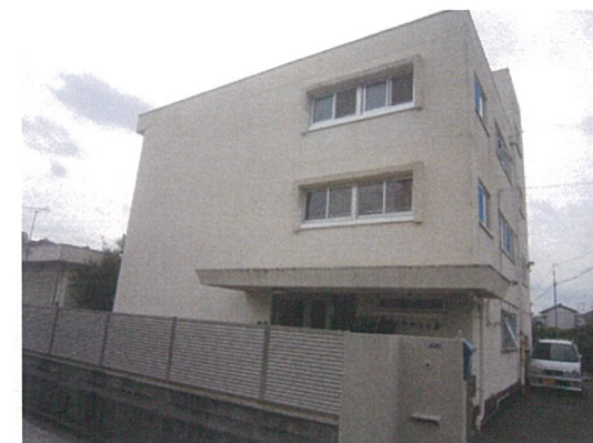
東面外観 (改修後)
