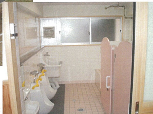
園児用トイレ（改修後）
