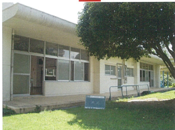
北面外観（改修前）
