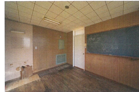
用具室（改修前）
