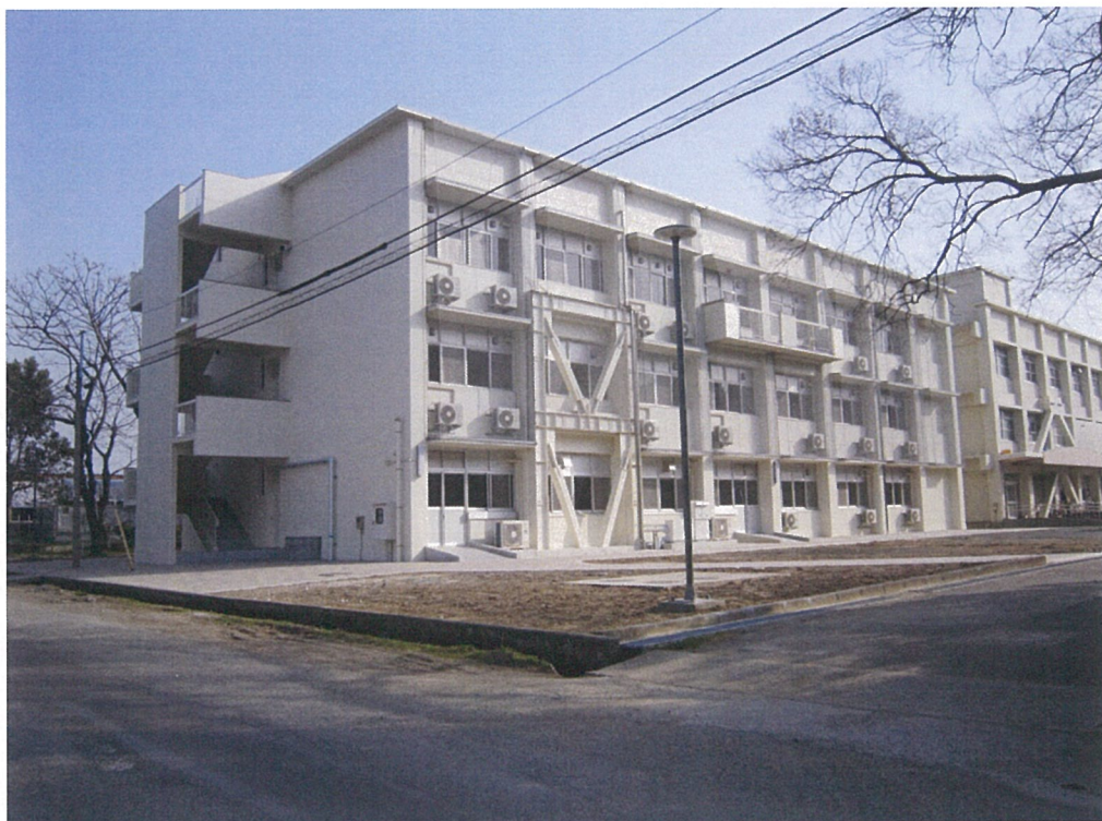
南西面外観 (改修後)
