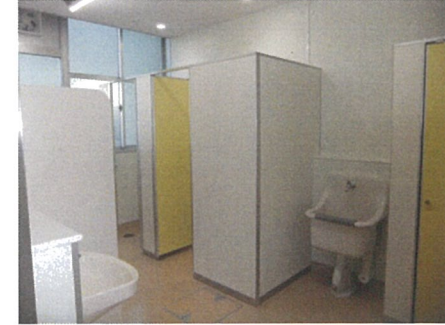
女子トイレ (改修後)
