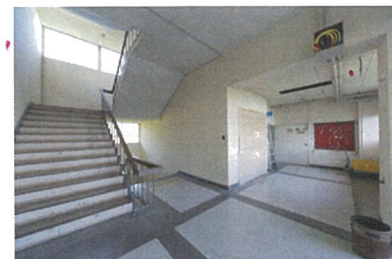
階段室 (改修前)
