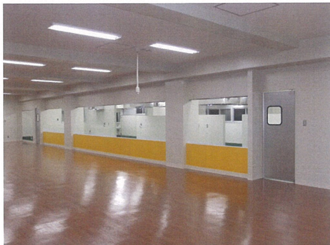
食堂～厨房（改修後）
