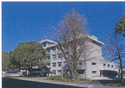
南東面外観（改修後）
