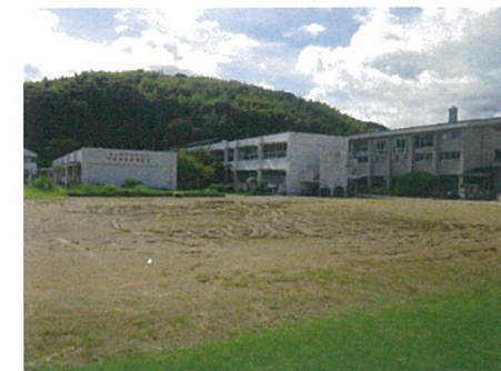
南東面外観（改修前）
