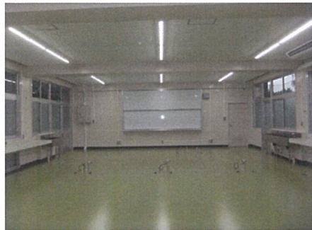
理科室 1 (改修後)
