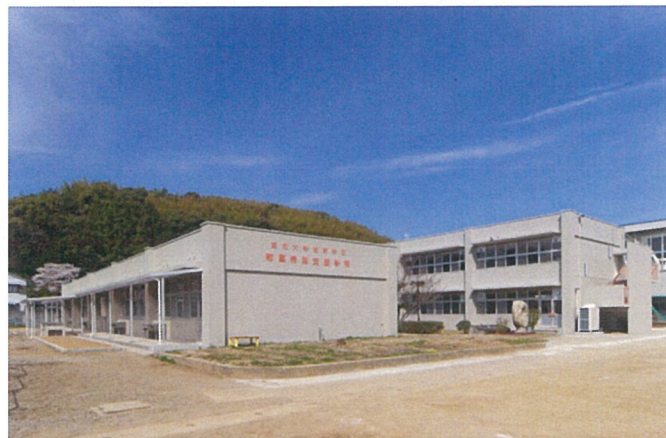
南東面外観（改修後）
