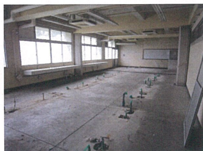
実験室 (改修前)
