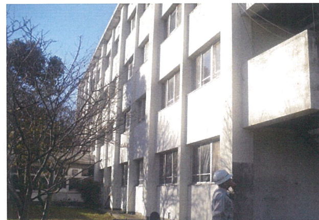
日章寮南面外観（改修前）
