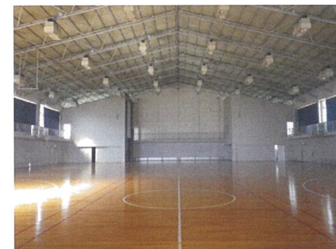
体育室 (改修前)
