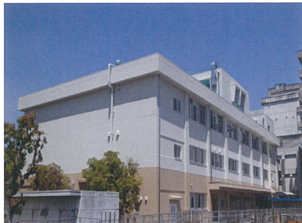
南西面外観 (改修後)
