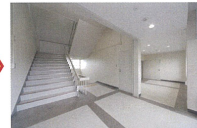
階段室 (改修後)
