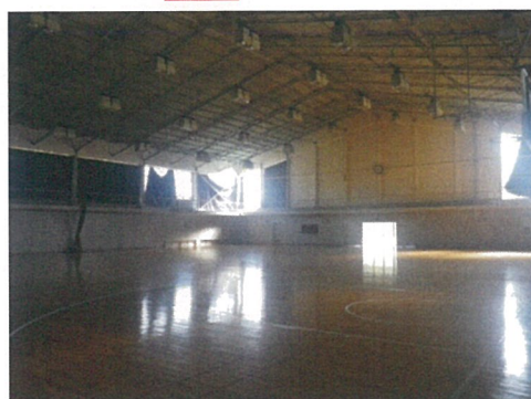
体育室 (改修前)
