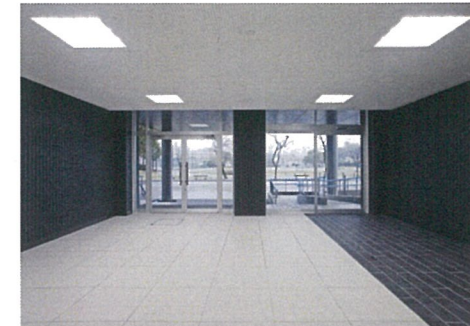
玄関・ホール（改修後）
