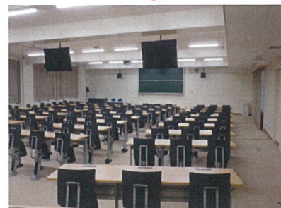
第5実習室を講義室2に改修
