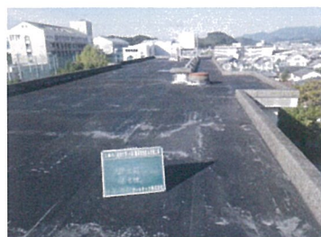
1号棟屋上 (改修前)
