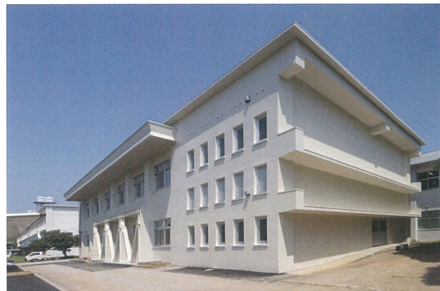
南東面外観（改修後）
