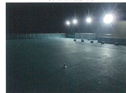
夜間照明設備
