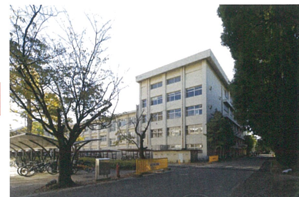
北西面外観 (改修前)
