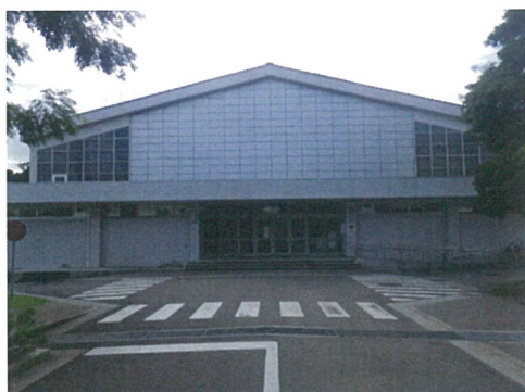
東面外観 (改修前)
