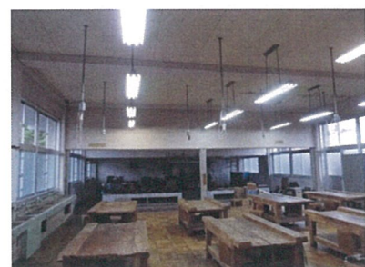
技術教室 (改修前)
