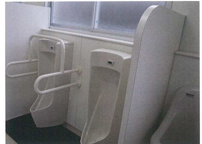
男子トイレ（改修後）
