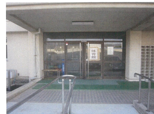
体育館玄関 (改修前)
