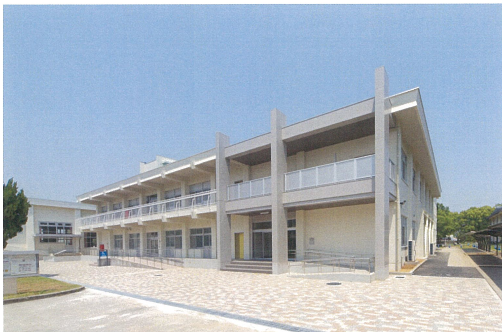
西南面外観（改修後）
