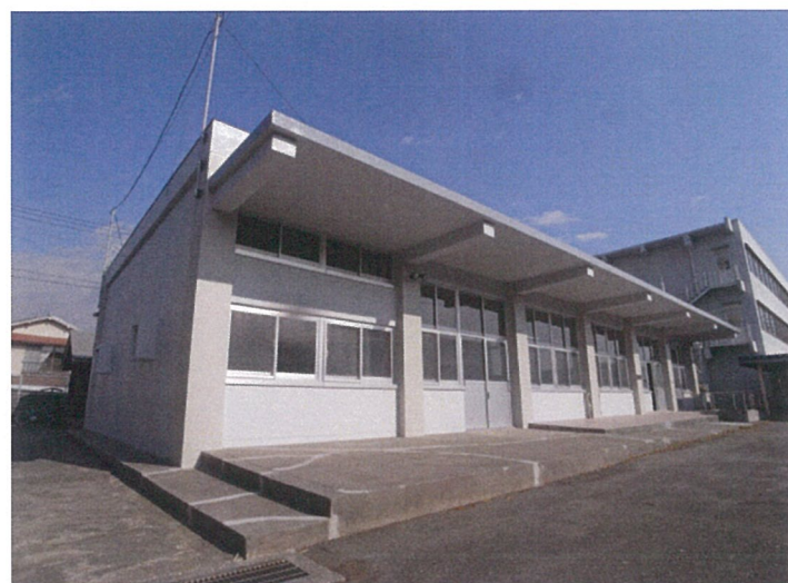
南西面外観 (改修後)
