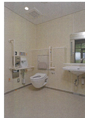
多目的トイレ
