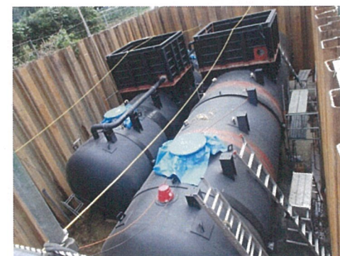
地下タンク (埋戻し前)
