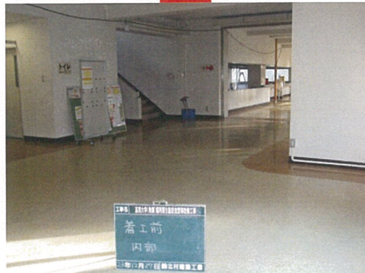
ホール（改修前）
