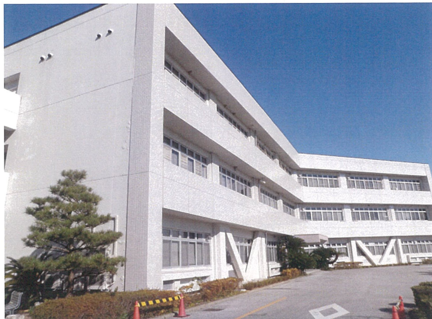
南面外観 (改修後)
