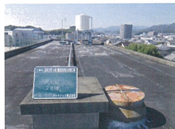
2号棟屋上 (改修前)
