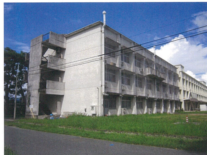
南西面外観 (改修前)
