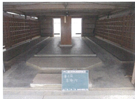
昇降口 (改修前)
