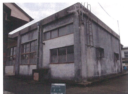
北西面外観 (改修前)
