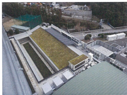
太陽光発電パネル・屋上緑化防水
