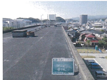
3号棟屋上 (改修前)
