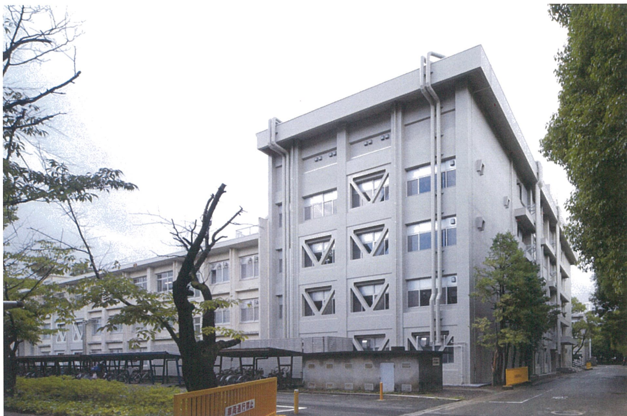
北西面外観 (改修後)
