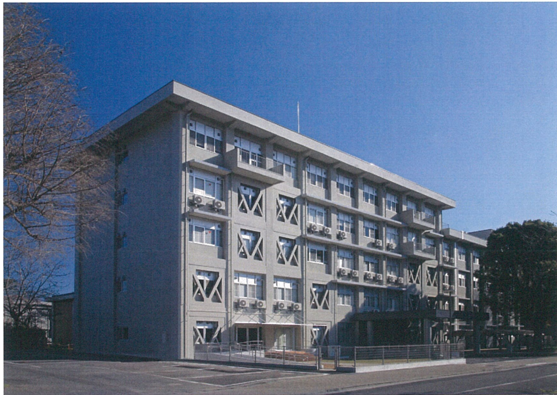
南西面外観（改修後）
