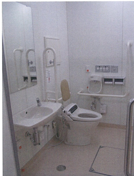
多目的トイレ新設
