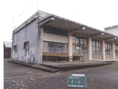
南西面外観 (改修前)
