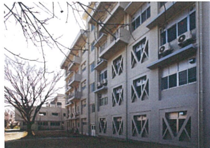
北面外観（改修後）
