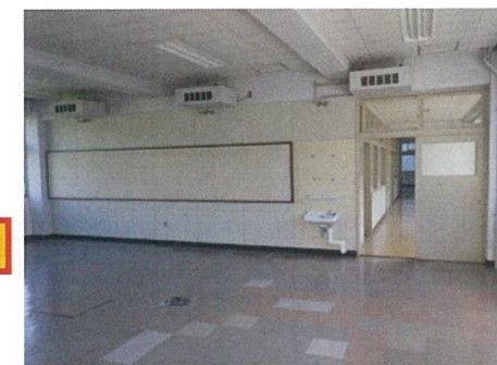
職員室（改修前）
