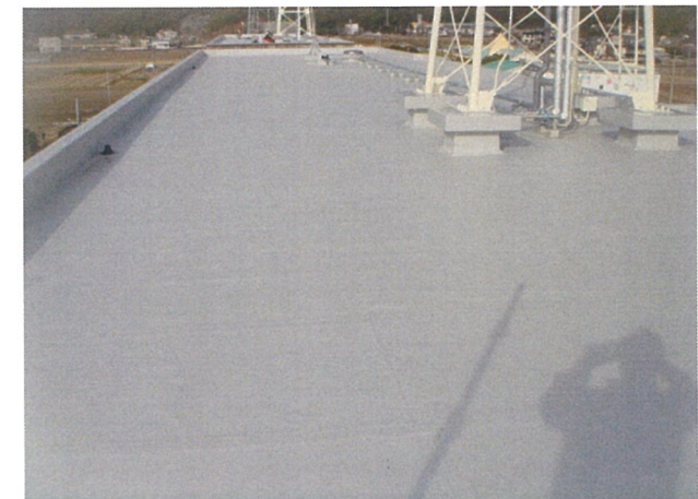
屋上防水 (改修後)
