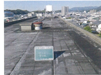
4号棟屋上 (改修前)
