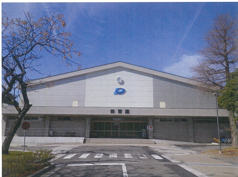
東面外観 (改修後)
