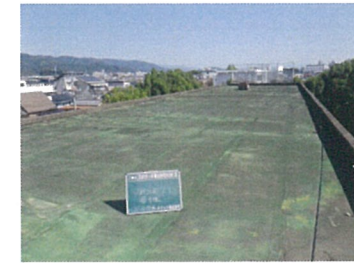
5号棟屋上 (改修前)
