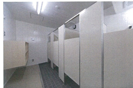
シャワー室（増築）
