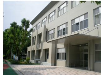
外観のデザイン要素としたPcコンクリートによる耐震補強（実験系総合研究棟・理学部1号館）
