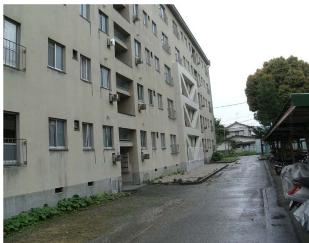
耐震工事が完了した小津宿舎
