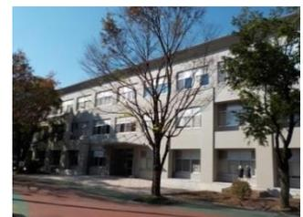
コンクリート製フレームによる耐震補強をデザイン要素とした理学部1号館
