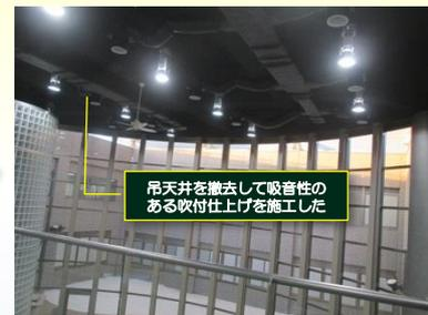
吊天井を撤去して吸音性のある収付仕上げを施工した
