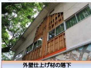
外壁仕上げ材の落下
