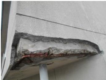
鉄筋の爆裂による
