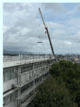
改修工事中(第1期)の様子
