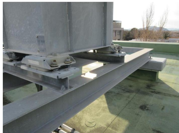
各棟屋上に設置された免振構造を持つ非常用電源装置
