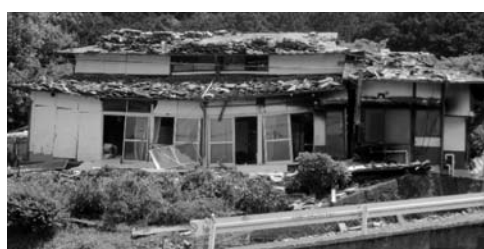
図3 地盤崩壊による木造住宅の被害
