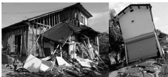
図3 地盤崩壊による木造住宅の被害
