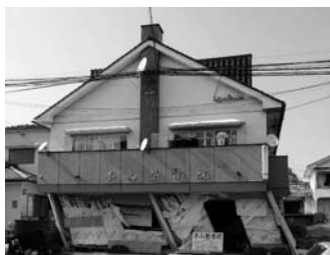
図1 壁不足による木造住宅の被害
