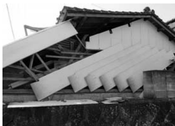
図1 壁不足による木造住宅の被害
