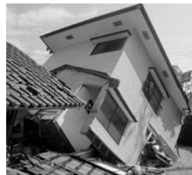
図2 接合部配慮不足による転倒
