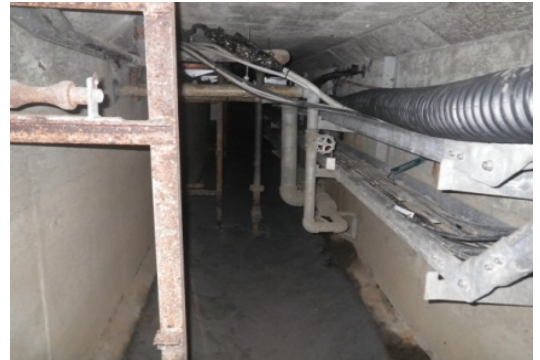
朝倉団地共同溝内現状
