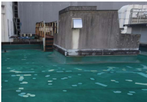
改修前：老朽化により 部分補修を繰り返した防水シート （令和3年度（岡豊）RI・動物実験棟屋上防水改修）
